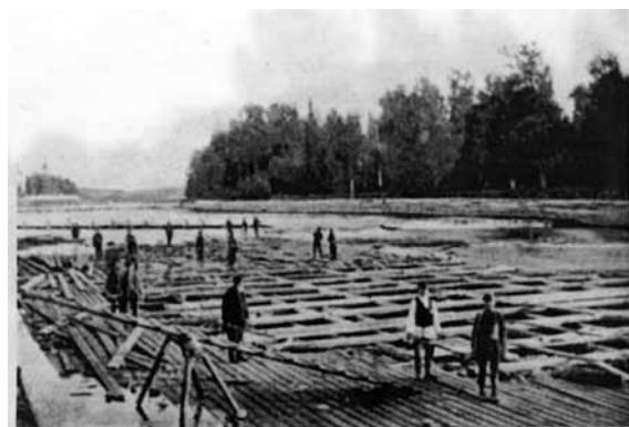
Устройство деревянного ростверка (1901)
